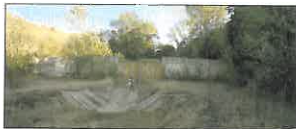
Fig. 6. Baraj din plăci plane pe contraforți
