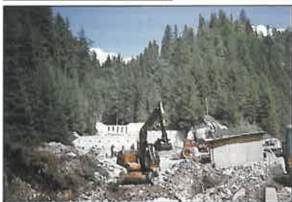
Fig. 3. Un ghid de bună practică în privința soluțiilor de execuție mecanizată a lucrărilor de amenajare a rețelei hidrografice torențiale
