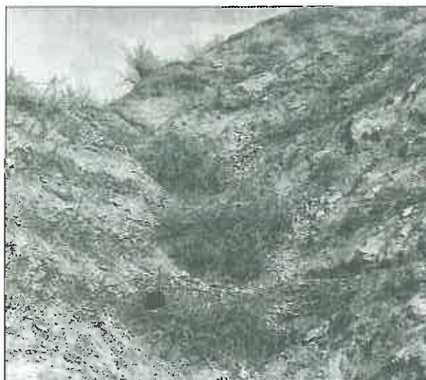
Foto 4. Praguri vegetative pe ogășe, continuate cu terase armate pe versanți în perimetrul experimental Bârsești – Vrancea (foto E. Untaru, 1978)
