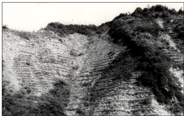
Foto 2. Terasse armate vegetal în perimetrul experimental Bârșești – Vrancea (foto E. Untaru, 1980)
