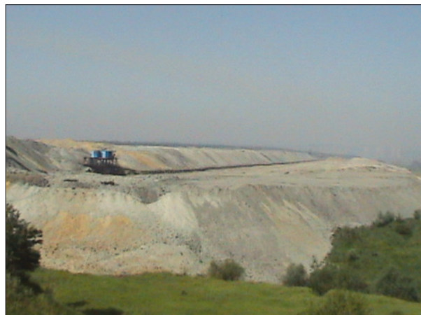
Foto 1. Haldă în construcție
