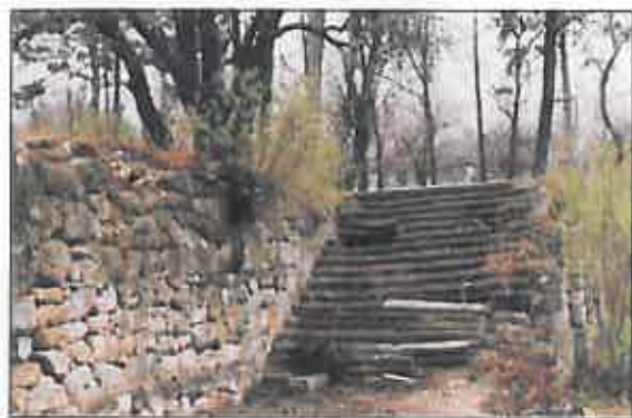
Foto 3 Trepte realizate în piatră (original, 2006)
