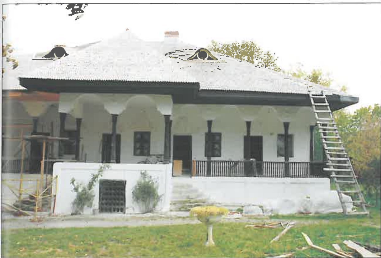
Foto 5 Fațada principală Conacul Bellu (noiembrie 2007, original)
