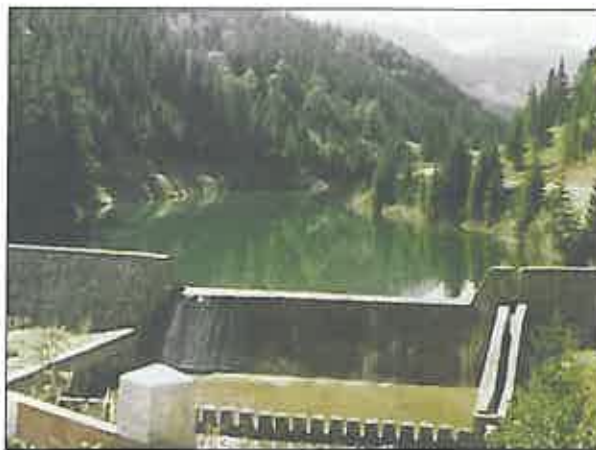
Împotriva aceluiași pericol, s-au executat lucrări și pe văile torențiale din jurul Lacului Roșu.
