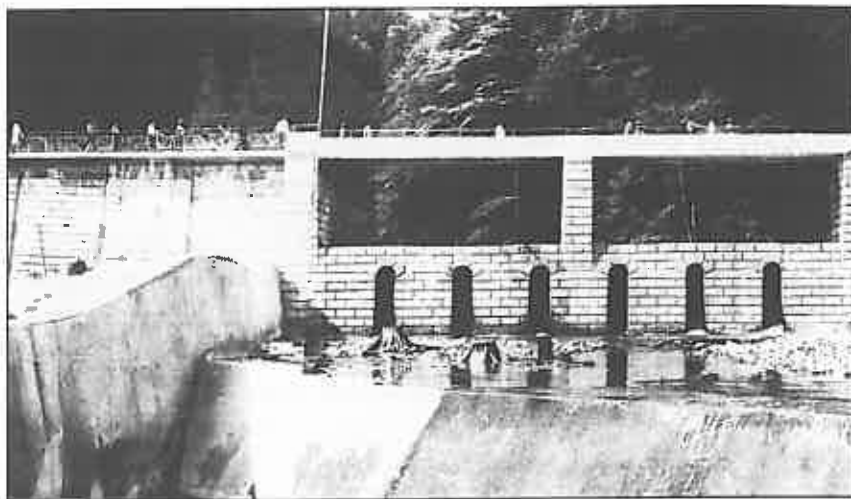
Fig. 1. Baraj de greutate din beton cu eforturi de întindere în paramentul amonte și cu ambii paramenți înclinați, filtrant, la un an de la construire.
