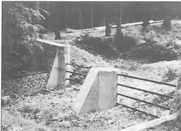
Foto 7. Baraj greblă din contraforți și bare de oțel (șine de cale ferată) pe Valea Urlătoarea, Poiana Țapului – Prahova, înainte de a fi blocat de flotanți (Gaspar, 1967).
