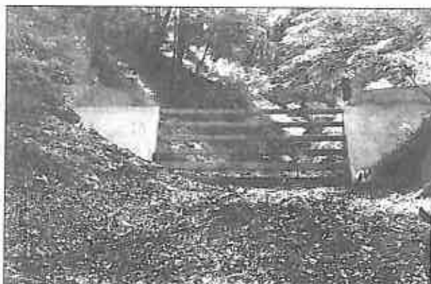
Foto 10. Barajul greblă 4B3,0 din grinzi de beton, încastrate în culee de zidărie (Valea Tirului-Valea Rea-Sinaia), pentru protecția barajului din foto 9, înainte de a fi distrus de flotanți (foto 11). (Gaspar, 1964).
