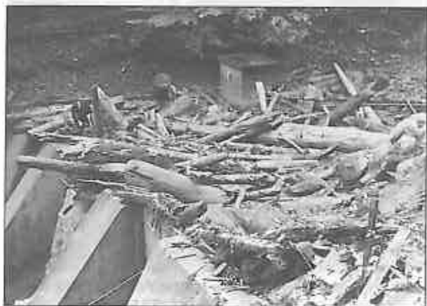
Foto 3. Blocarea totală a deversorului triunghiular din foto 9, de către flotanți, pe Valea Tirului, Valea Rea-Prahova-Sinaia. (Gaspar, 1972).
