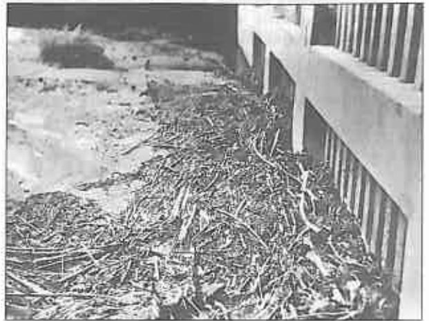
Foto 8. Aglomerarea de flotanți de mici dimensiuni, amonte de barajul filtrant 2B5,0 de pe Valea Ursului–Râul Târgului, Lerești (în prezent colmatat integral). Gaspar, 1965.
