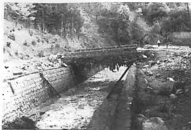
Fig. 4. Sectorul amonte al canalului de pe Valea Păltiniș (Bâsca, Buzău). Flotanții reținuți de tablierul podețului - cei mai credibili martori ai nivelului maxim al viiturilor din anul 1991 (foto: Gaspar, 1992).
