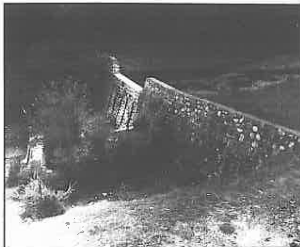
Fig. 3. Barajul 3M3,0 de pe Valea lui Ecle - B. H. Dâmbovița. Se observă procesul de spălare a aterisamentului, în zona de albie din spatele fantelor (foto: Gaspar, 1992). această figură.
