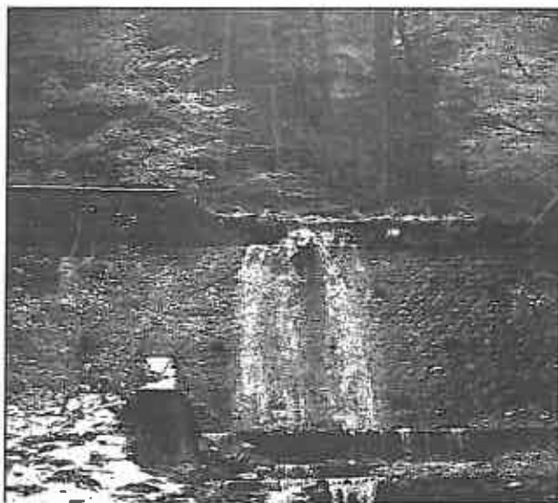
Fig. 1. Deversor „blocat” la un baraj de pe Valea Urlătoarea Mică - B. H. Prahova (foto: Clinciu, 2006).
