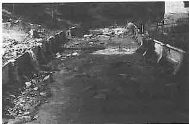
g) - Amenajarea nereușită a albiei torentului Nehoiu: zidurile de conducere a apelor și de consolidare a malurilor nu sunt perfect paralele, au multe coturi și sunt realizate din plăci armate pe contraforți dispuși spre axul văii, unde pot provoca vârtejuri în timpul viiturilor, care le-au și distrus pe unele secțiuni - 1992)
