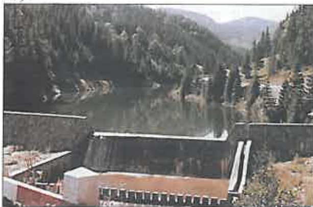
Foto 3. Lucrări de corectare a torenților. (foto A. Costin)
