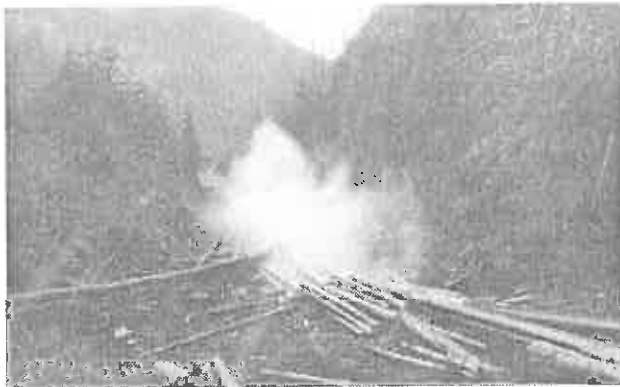
Bușteni de molid alunecând pe scoc de apă cu o viteză extraordinară
