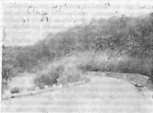
Fig. 3. Vedere de ansamblu a serpentinei Nr. 1 (Pr. Colceului - Pr. Smidei). Taluz de debleu consolidat la baza cu zidărie de piatră și mortar de ciment. În continuarea zidăriei plantații de anin alb și cătina albă. Foto: R. Angelescu, 1980
