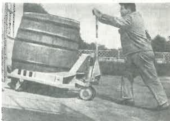
Fig. 6. Modul de deplasare a căruciorului în pantă.
