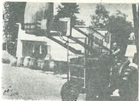
Fig. 2. Adaptarea încărcătorului pentru stivuirea butoaielor la înălțimi mari.
