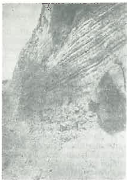
Fig. 2. Peretele de ruptură a alunecării.
