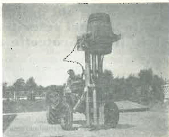
Fig. 4. Modul de stivuire a butoaietele la înălțimi mari.
