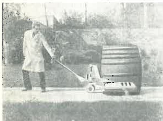
Fig. 3. Manevra de deplasare a căruciorului cu butoiul.
