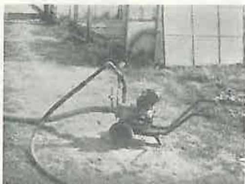
Fig. 3. Motopompa cu motor Dicați, cu ștufuri și cărucior de transport.
