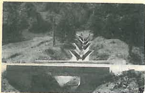
Fig. 1. Canal pe albia unui torent din b.h. Dimbovița pentru apărarea drumului forestier. Foto : A. Costin.
