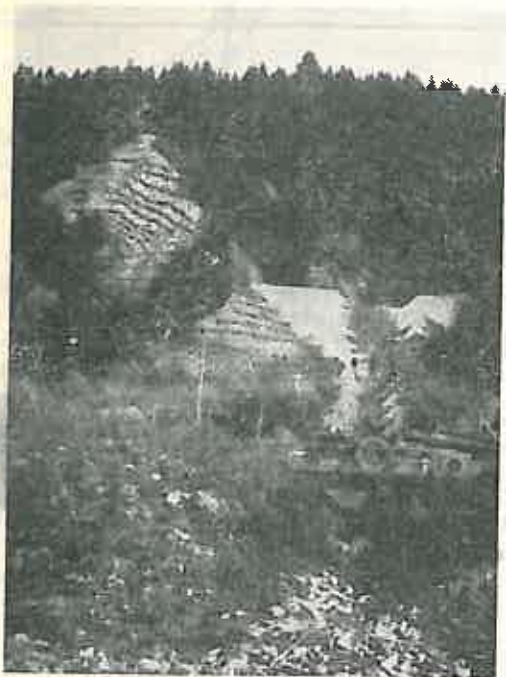
Fig. 1. Lucrări de artă — retenție și evacuare, lucrări de consolidarea malurilor — gardulețe — și plantații cu salcie pe depunerile conului de dejecție al piriului Virlanu, în perimetrul Galu (foto: V. Voinea).
