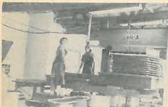
Fig. 4. Producerea sucurilor din fructe de pădure cu ajutorul preseii hidraulice.
