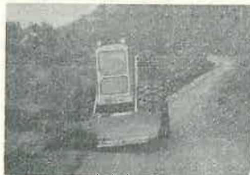
Fig. 8. Utilajul IFRON lucrind la tăierea acostamentelor cu lama de săpat și nivelat.
