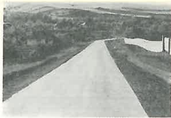
Fig. 5. Aspect al drumului cu comportare corespunzătoare.
