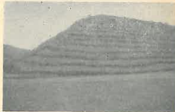
Fig. 4. Refacere de arborete degradate prin metoda benzilor.
