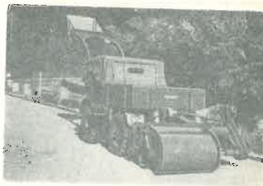
Fig. 4. Freză pentru curățirea banchetelor drumului.
