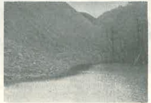
Fig. 4. Partea amonte a haldei de steril care barează Pr. Renghii-Lupeni, formînd un lac de acumulare (există pericolul subminării bazei și alunecării).
