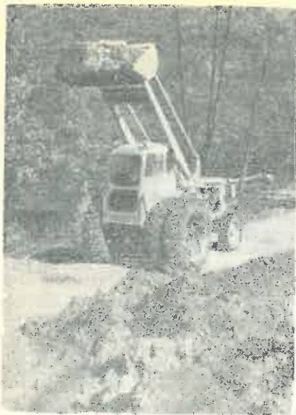
Fig. 7 b. Utilajul IFRON, lucrind la înălțarea ebulmenților cu cupa de 0,8 m 3 .
