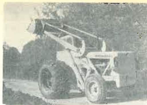
Fig. 7 c. Utilajul IFRON lucrind la împrăștierea agregatelor pe platforma drumului cu cupa de 0,8 m 3 .
