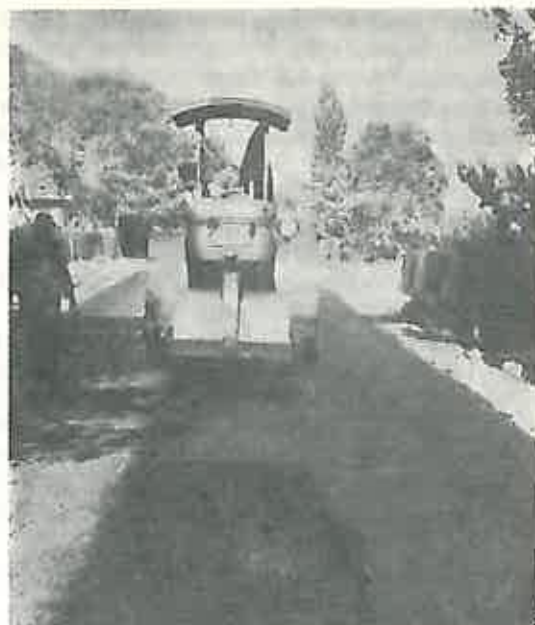
Fig. 3. Compactarea îmbrăcăminții pe drumul auto Tarcău.
