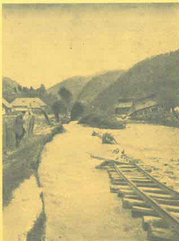
Instalații de transport forestiere scoase tem- porar din funcțiune
