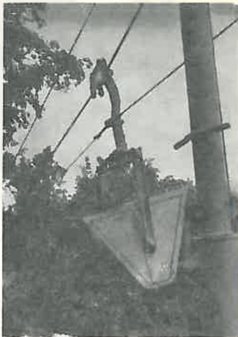
Fig. 4. Vagonetul funicularului T. 700 echipat cu cupa pentru transportul betonului sau mortarului.
