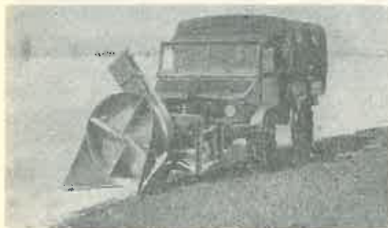
Fig. 6 a. Freza de zăpadă cu un rotor.
