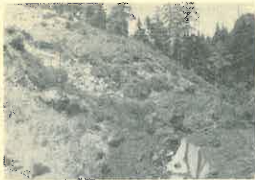
Fig. 4. Masa alunecată de pe dreapta văii a barat valed la km 9,3. În spatele barajului s-a format un lac, iar apa deversează la nivelul liniei ferate distruse.
