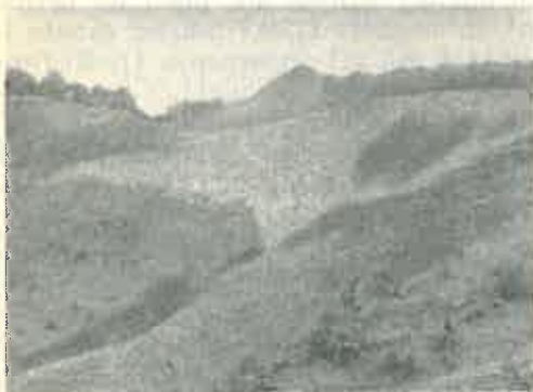
Fig. 3. Halda de steril care barează Pr. Renghii-Lupeni și are formate deja ogașe.
