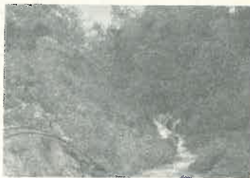
Fig. 3. O parte a masei alunecate care a barat valea Cașoca la km 4,5; deversorul și o parte din linia forestieră.
