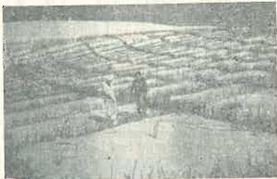
Fig. 3. Sistemul mecanic de fixare a dunelor maritime printr-o rețea de gîrdulețe formate din stuf, la El Qasr.
