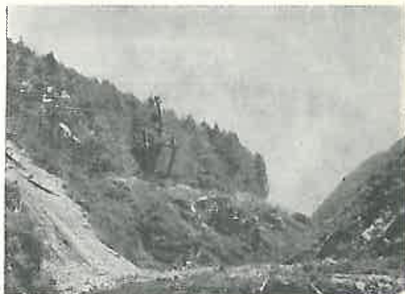
Fig. 8. Funicularul T. 700 în lucru la drumul forestier Valea Rea — Capra (bazinul Argeș). Traversarea râului Capra.
