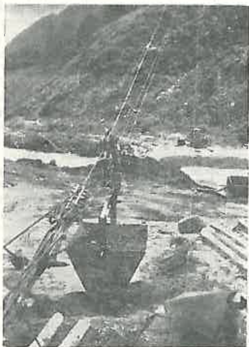
Fig. 7. Funicularul T. 700 în lucru la drumul forestier Valea Rea—Capra (stația de încărcare).
