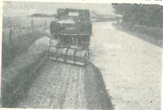
Fig. 1. Lama de profilat din spate în lucru.
