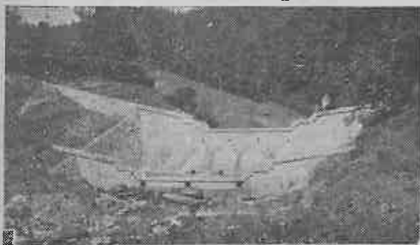
Fig. 4. Oaspeții cehoslovaci au apreciat că barajele de zidărie bine executate, asigură alături de vegetația forestieră, reținerea marilor transporturi aluvionare de pe pârul Buhalnița, din bazinul Bistriței.
