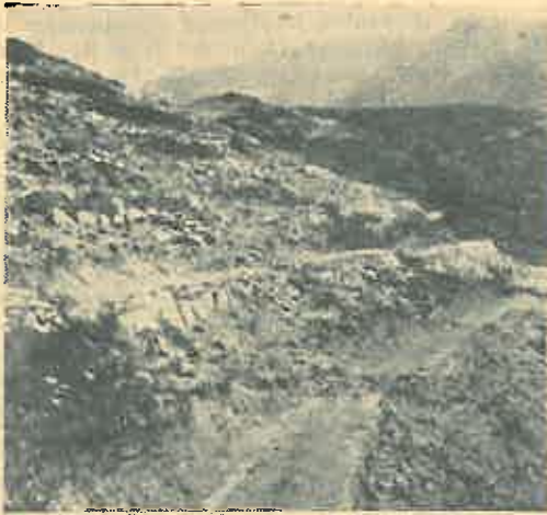
Foto. 3. — Terasarea unui versant din bazinul Idbar, cu ajutorul banchetelor susținute de piatră. — doc. FAO —
