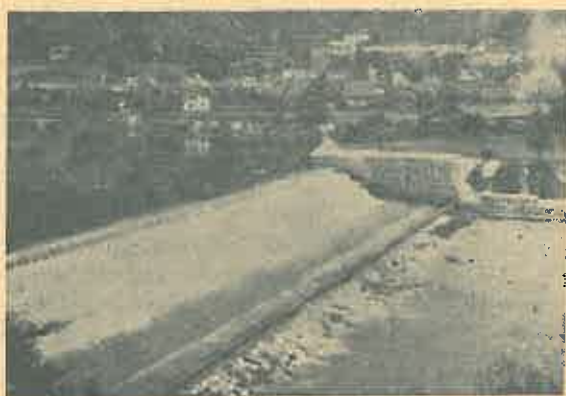
2. Baraj de retenție pe râul Sava, pentru retenția aluviunilor în amonte de lacul de acumulare al hidrocentralei Moste, la Yawornik (R. P. Slovenia) din gabioane; executat în 1954 — documentație FAO —
