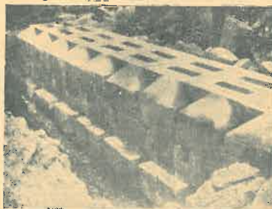
5. Barajul dren, sistem Rosici, detaliu al drenului
