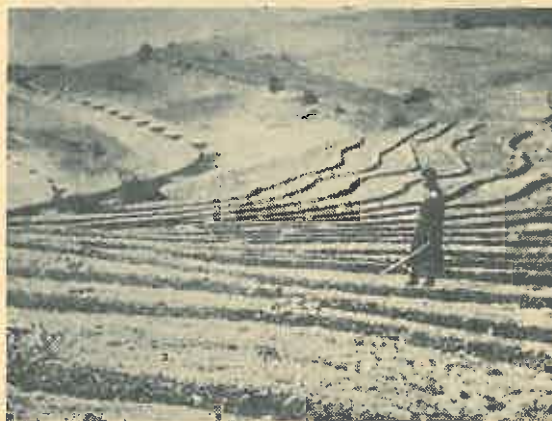
Foto. 1. — Un ansamblu de lucrări hidrotehnice — șanțuri orizontale și brazde — doc. FAO —
