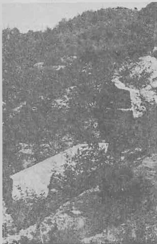
Fig. 2. La adăpostul lucrărilor de artă—baraie—vegetația pune stăpânire pe terenul degradat și-l redă producției. — Perimetrul de ameliorare Comarnic-Valea Prahovei.
