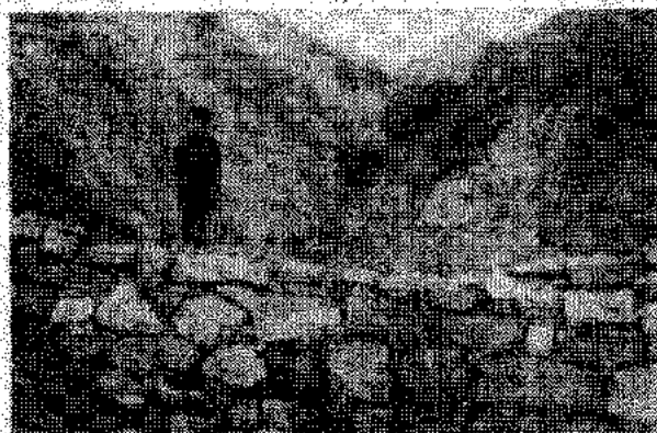
Fig. 4. Perimetrul Muereasca. Baraj de zidărie uscată, acoperit în o lună și plantat imediat cu puieți de plopi negri hibridi.
