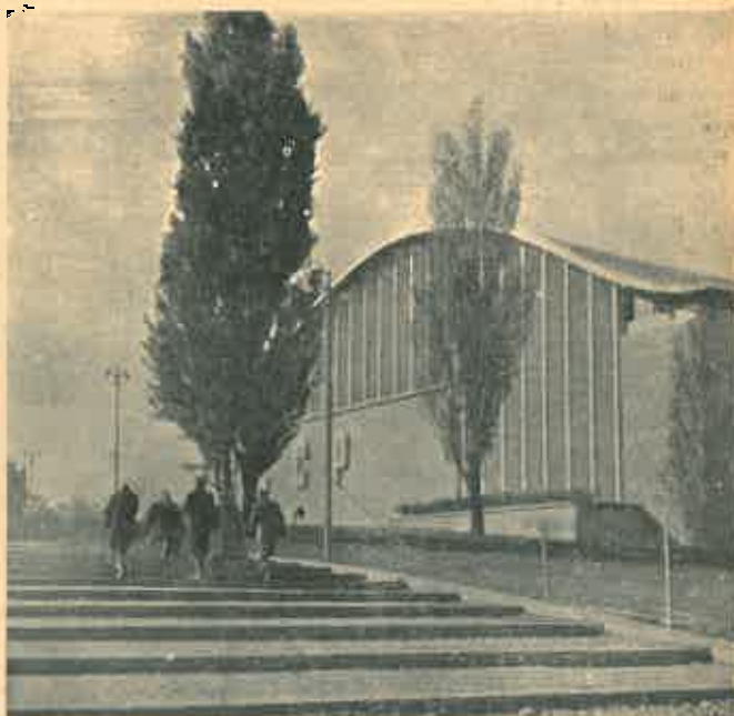
Fațada dela sud
