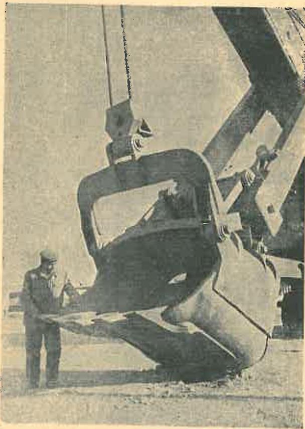
Cupa de 3 m. c. a Excavatorului U.Z.T.M.-S.E. 3
