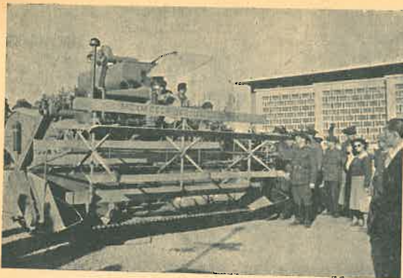
Combina Stalineț S. 4 pentru secerat, treerat și recoltat autopropulsată.
