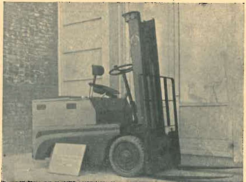
Auto-încărcător electric pentru 1,5 tone.
