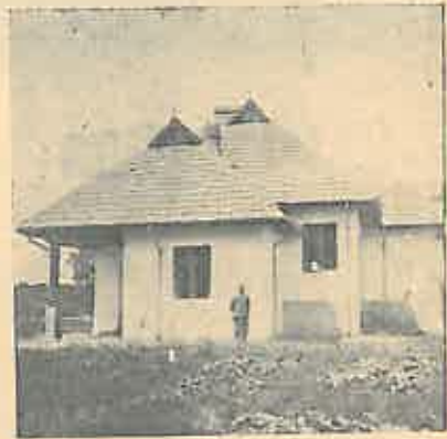
Fig. 1. — Canton de brigadier silvic, având și 2 camere pentru scopuri vânătoarești. (Ocolul Ghimpați-Viașca)
