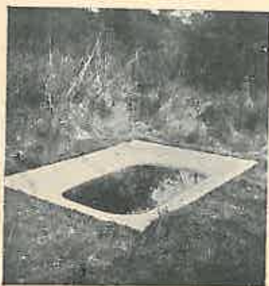
Fig. 3. Basin pentru apă, construit din beton, pe terenul de fazani dela ocolul silvic Pohrlitz, destinat a remedia lipsa de apă pe timp de secetă.
