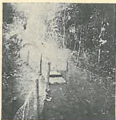
Fig. 3. Basin pentru apă, construit din beton, pe terenul de fazani dela ocolul silvic Pohrlitz, destinat a remedia lipsa de apă pe timp de secetă.
