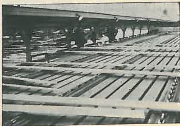
Fig. 3. — Rampa de sortarea chereștelei la fabrica Kalix.
