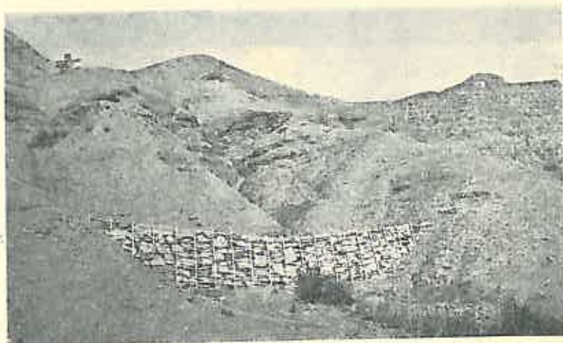
Fig. e. Baraje simple în piatră uscată armată. Seria Marcoux (Basses-Alpes) 1935.
