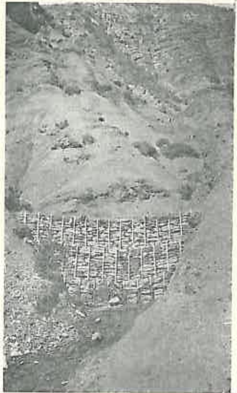
Fig. h. Baraje mici în piatră uscată armată. Dispozitiv în trepte. Seria Marcoux (Basses-Alpes) 1935.
