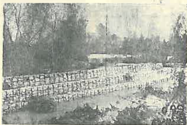
Fig. 6. Lucrări de apărarea malurilor unui râu. Zidărie uscată armată 1931.
