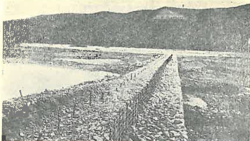
Fig. p. Pinten de 65 metri lungime construit în albia unui râu în Ianuarie 1931. Se vede în b flarele de ancorare înșepenite cu pietre.
