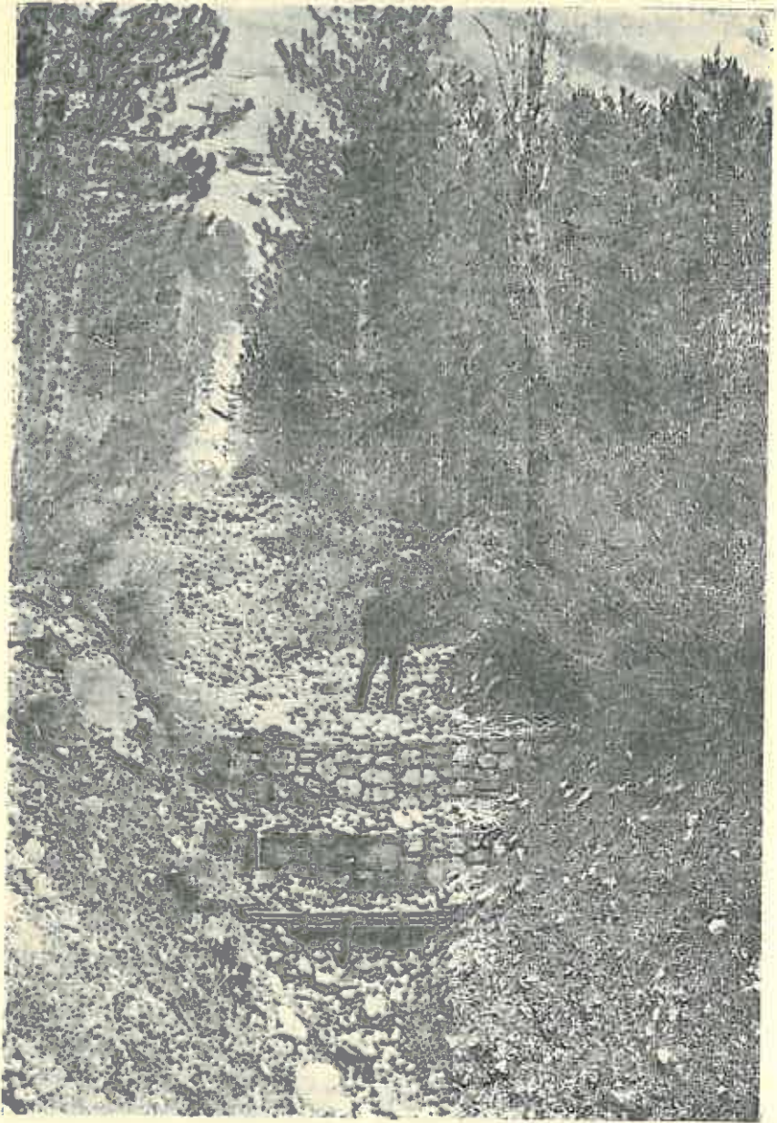
Fig. a. Baraje mici în piatră uscată armată. Se vede construcția în trepte. Seria Barrême (Basses-Alpes) 1930.
