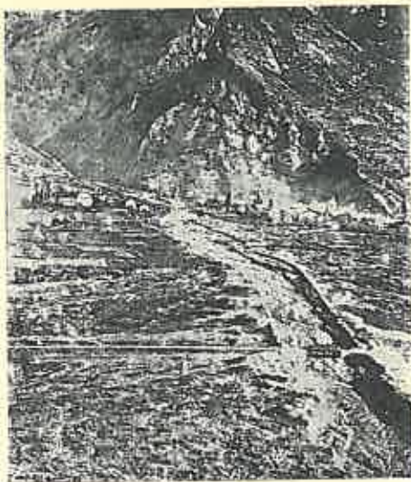
Foto Nr. 7. — Conul de dejecție al torentului St. Julien-en-Maurienne înainte de a se fi construit canalul de scurgere.
