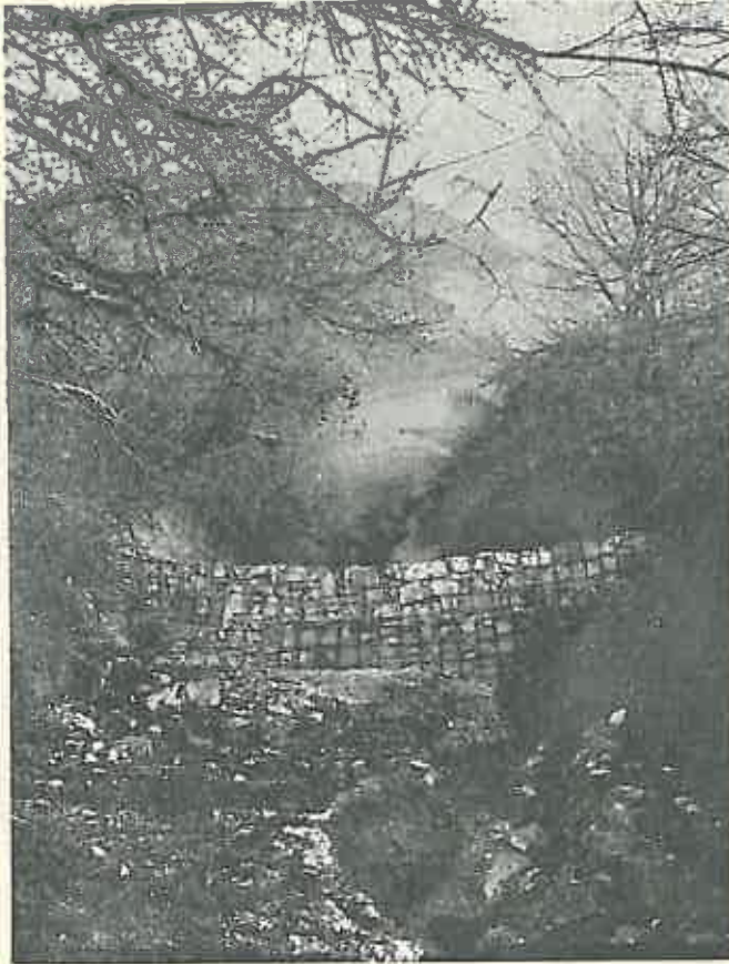
Fig. b. Baraje mici în piatră uscată armată. Se vede construcția în trepte. Seria Morlez (Basses-Alpes) 1929.
