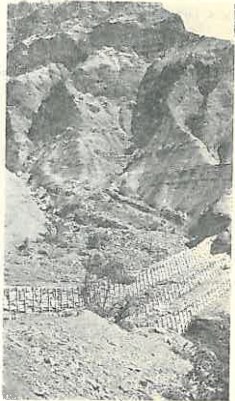
Fig. n. Lucrări de consolidare în piatră uscată armată.
