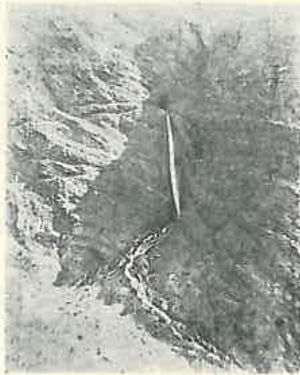
Foto Nr. 1. — Derivația torențului St. Julien-en-Maurienne, văzută din aval. Torentul are o cădere de 80 m.
