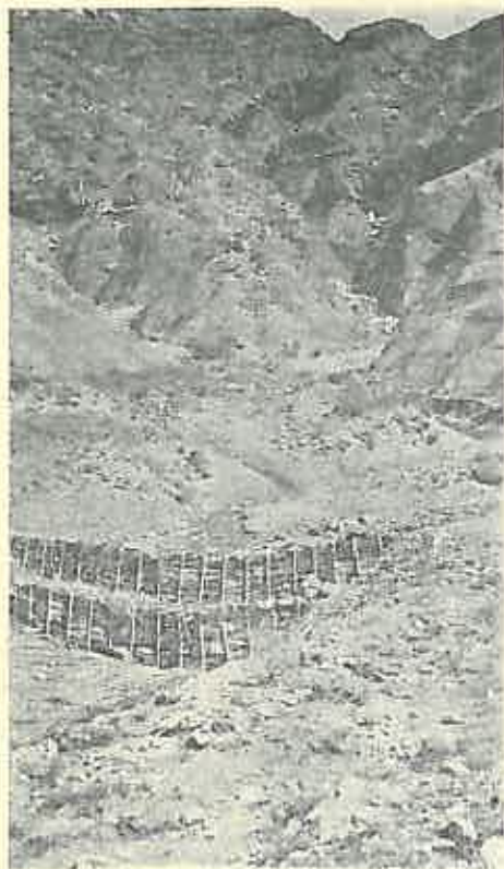
Fig. I. Baraje mici în piatră uscată armată. Se vede constituția geologică a terenului. Seria Marcoux (Basses-Alpes) 1935.
