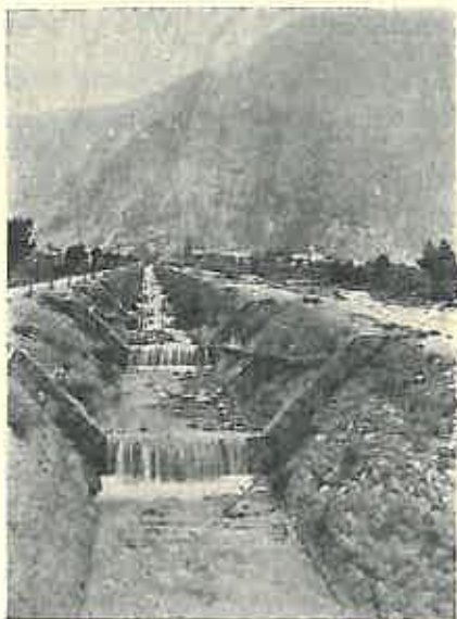
Foto Nr. 3. — Canalul de scurgere construit pe conul de dejecție al torentului St. Julien-en-Maurienne.
