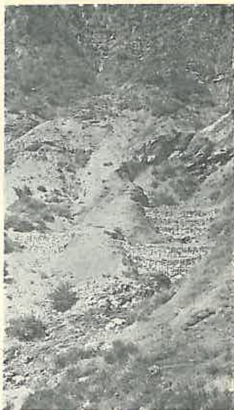
Fig. l. Baraje mici în piatră uscată armată. Se vede dispozitivul în trepte în apropiere de confluența a două ravene. Seria Marcoux (Basses-Alpes) 1935.
