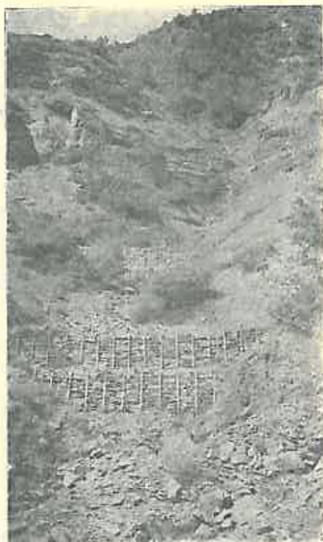
Fig. J. Baraje mici în piatră uscată armată. Se vede dispozitivul în trepte dealungul torentului. Seria Marcoux (Basses-Alpes) 1935.
