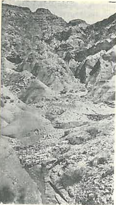
Fig. m. Baraje mici în piatră uscată armată. Se vede constituția geologică caracteristică a solului complet lipsit de vegetație. Seria Marcoux (Basses-Alpes) 1935.
