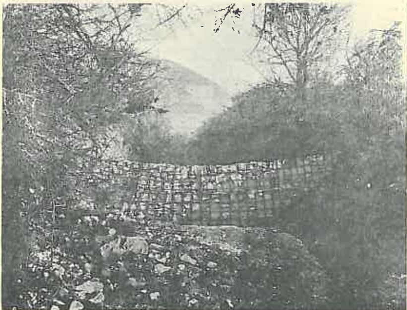
Fig. c. Baraje mici în piatră uscată armată. Se vede construcția în trepte. Seria Moriez (Basses-Alpes) 1929.
