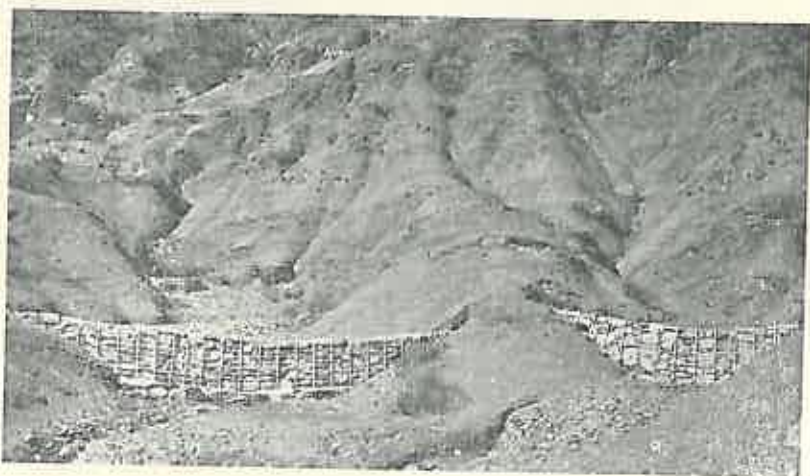
Fig. f. Baraje simple în piatră uscată armată. Seria Marcoux (Basses-Alpes) 1935.
