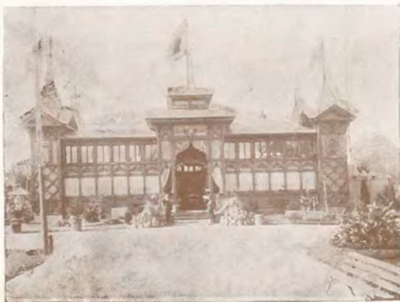
Fațada Pavilionului Domeniului Coroanei.
