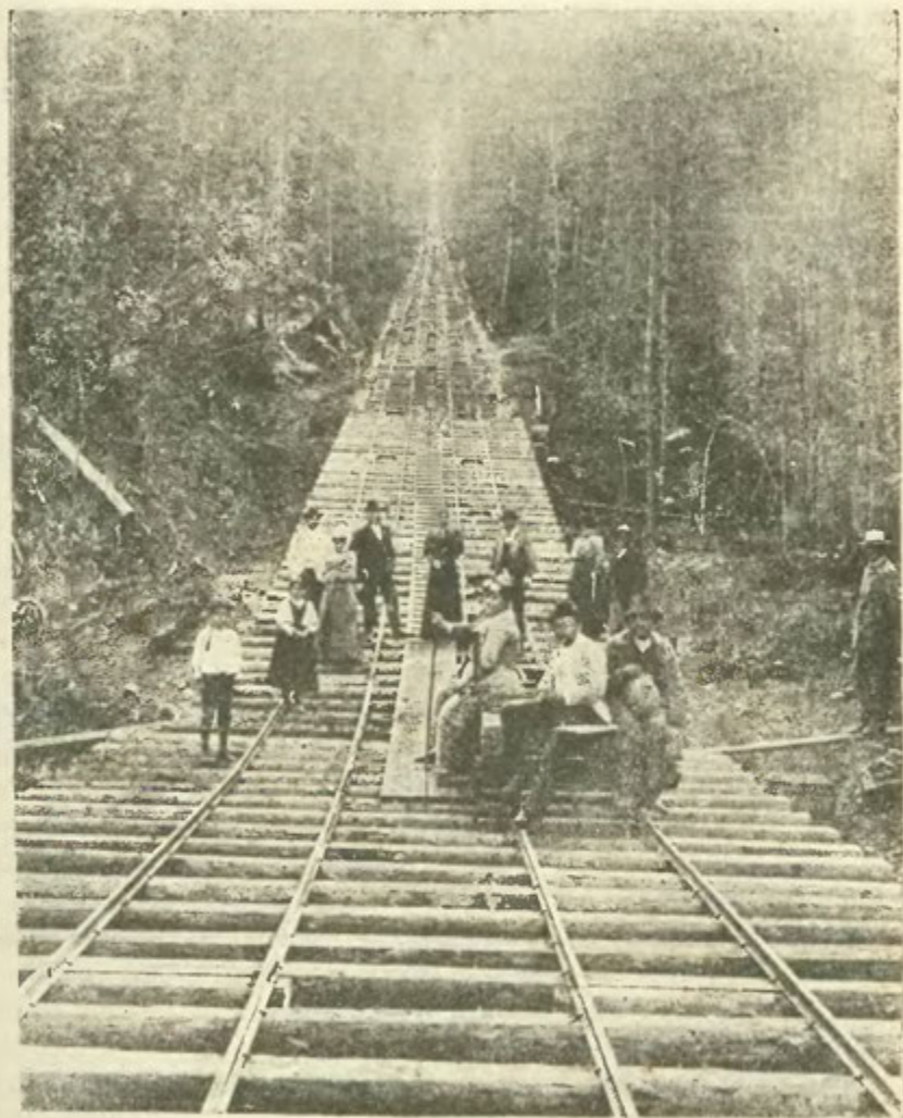
Prima cale ferată uniculară în România, comuna Malini, pentru exploatarea mecanică forestieră.
