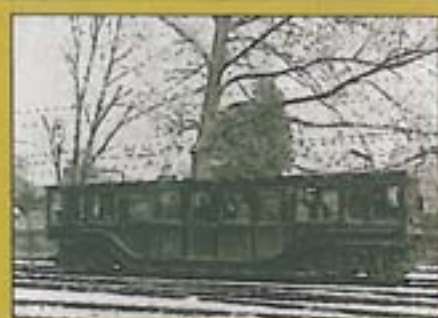
Primul vagon de metrou european, instalat de Siemens în Budapesta în 1896.
