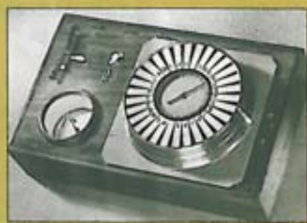
Telegraf perfecționat, inventat de Werner von Siemens în 1847.
