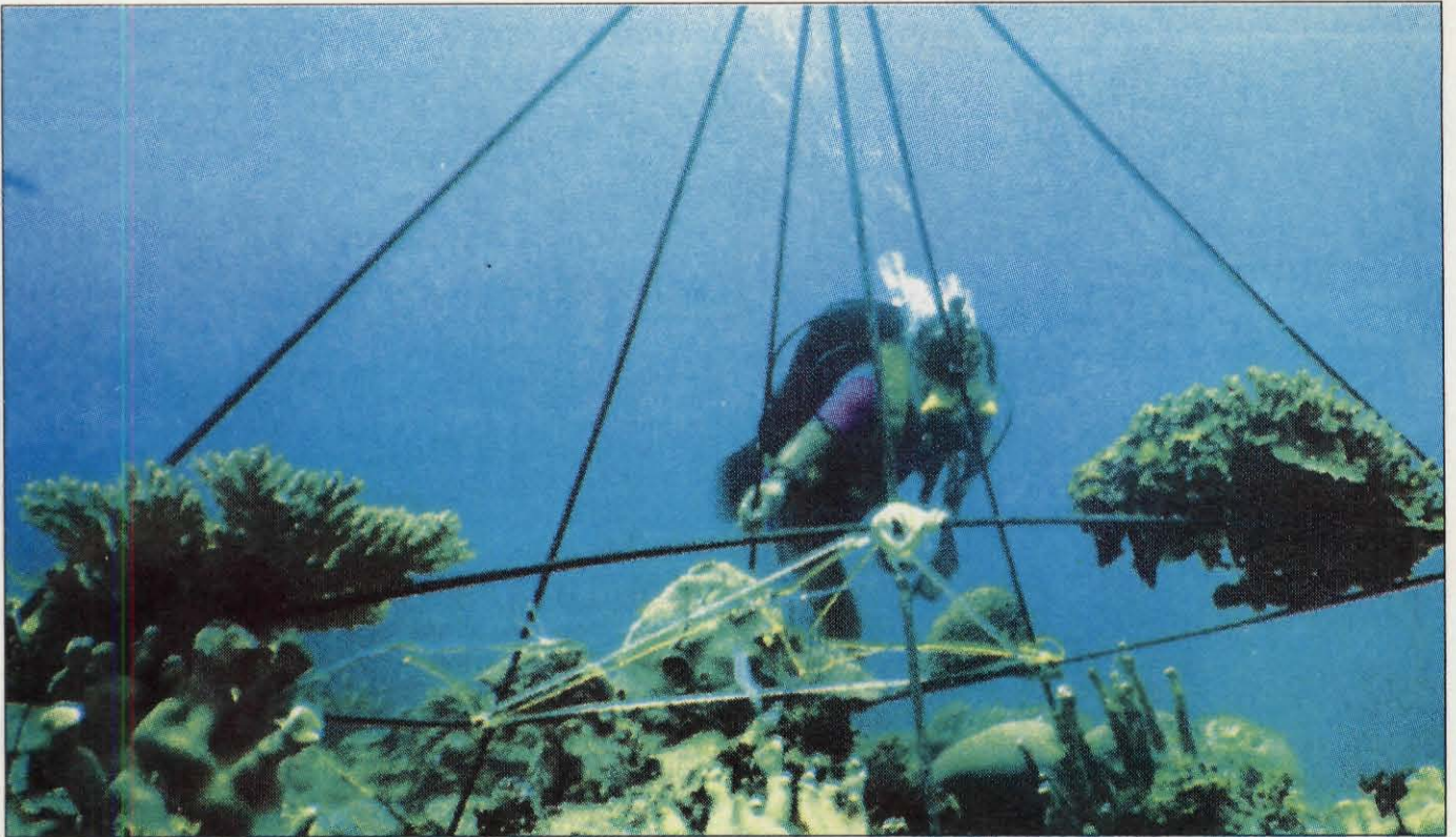
Montarea piramidei care va deveni în scurt timp structura de rezistență a insulei artificiale.
