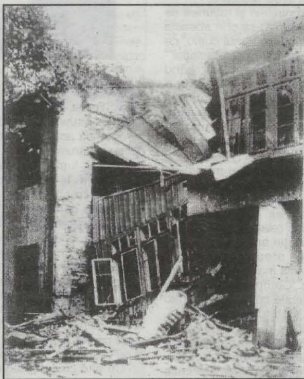
Clădiri din București distruse de bombardamentele inamice.
