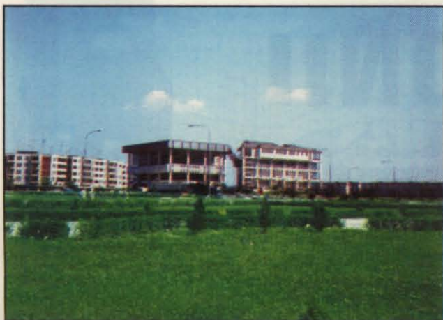
În Casa de cultură a tineretului din Baia Mare, fundația a încheiat contracte de închiriere, asociere și locație cu diferite societăți particulare. Una dintre utilizările date în prezent clădirii este cea de casă de rugăciune a unei secte religioase.
