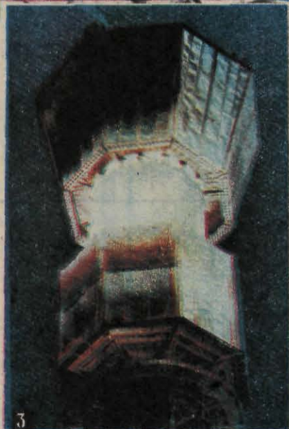
1 — Construcția primei centrale electrice solare din UR.S.S. înălțea de 89 m se vede de la mare departare 2 — Cele 1 500 de heliopanouri ale electrocentralei sînt dispuse în jurul turnului în 20 de cercuri 3 — Generator de abur solar. Suprafața de încălzire constă din panouri verticale, înalte de 7 m, dispuse pe 16 fațete
