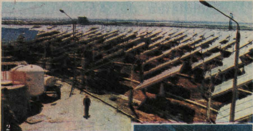
1 — Construcția primei centrale electrice solare din UR.S.S. înălțea de 89 m se vede de la mare departare 2 — Cele 1 500 de heliopanouri ale electrocentralei sînt dispuse în jurul turnului în 20 de cercuri 3 — Generator de abur solar. Suprafața de încălzire constă din panouri verticale, înalte de 7 m, dispuse pe 16 fațete
