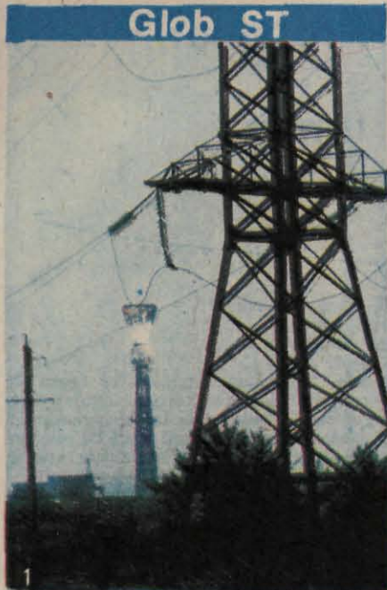
1 — Construcția primei centrale electrice solare din UR.S.S. înălțea de 89 m se vede de la mare departare 2 — Cele 1 500 de heliopanouri ale electrocentralei sînt dispuse în jurul turnului în 20 de cercuri 3 — Generator de abur solar. Suprafața de încălzire constă din panouri verticale, înalte de 7 m, dispuse pe 16 fațete
